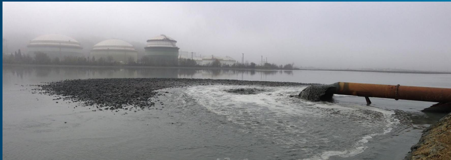
Il metodo “SLO”w con refluito intermittente tramite draga TSHD per circa 30% del tempo permette di riempire la colmata con materiale limoso ed argilosa al massimo livello senza perdite di materiale dragato altrove
