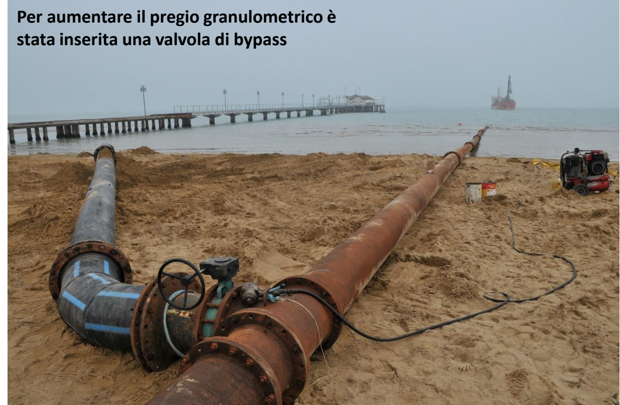
Inserimento valvola di by-pass
