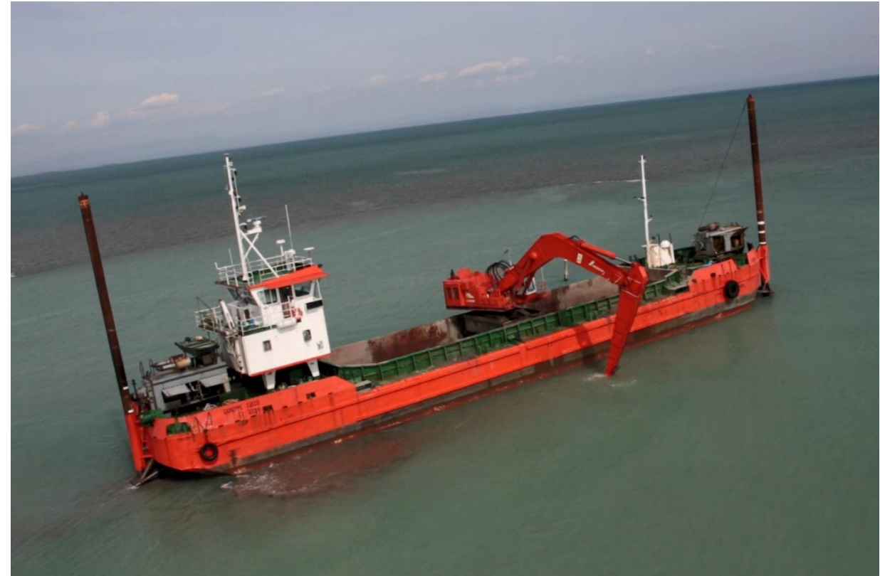
Dragaggio bettolina con escavatore idraulico
