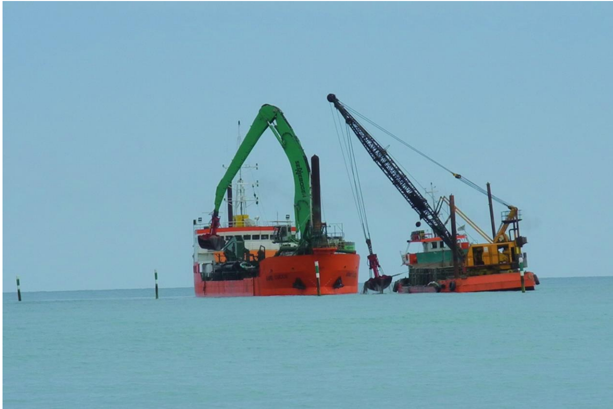
Dragaggio TSHD e pontone
