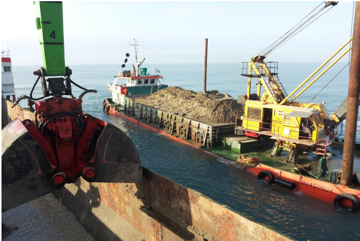
Trasbordo materiale sabbioso da pontone per aumentare la continuità della resa della TSHD
