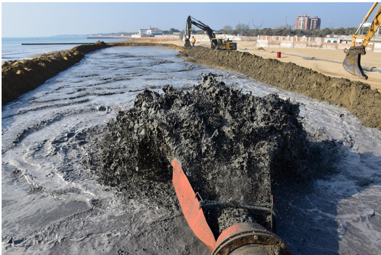
Refluitamento mediante diffusore a becco d'anatra
