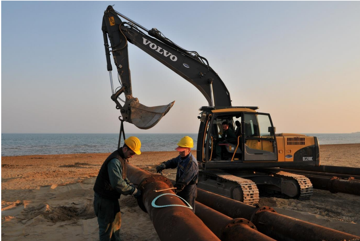
Assemblaggio condotta refluyente Ø400
