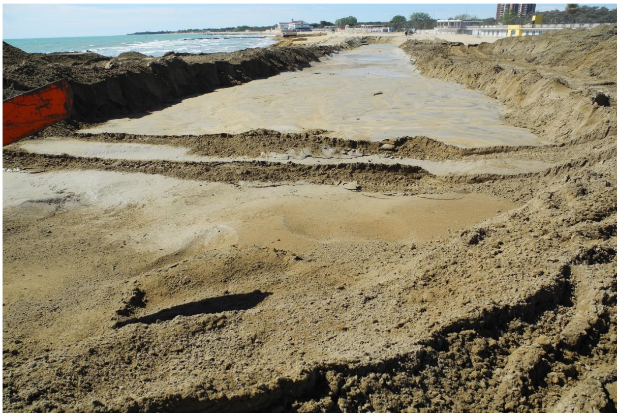
Riempimento e rialzamento argini perimetrali vasca
