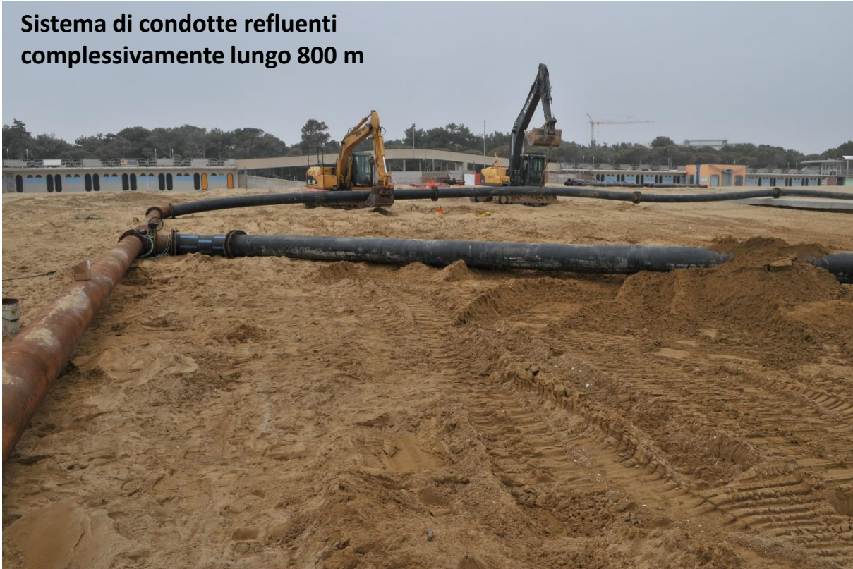
Allestimento condotta a terra
