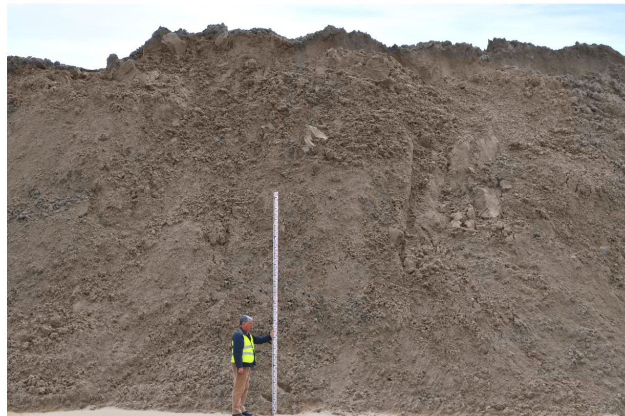
Ripresa materiale e formazione cumuli ( h_{\max} = 10 m)
