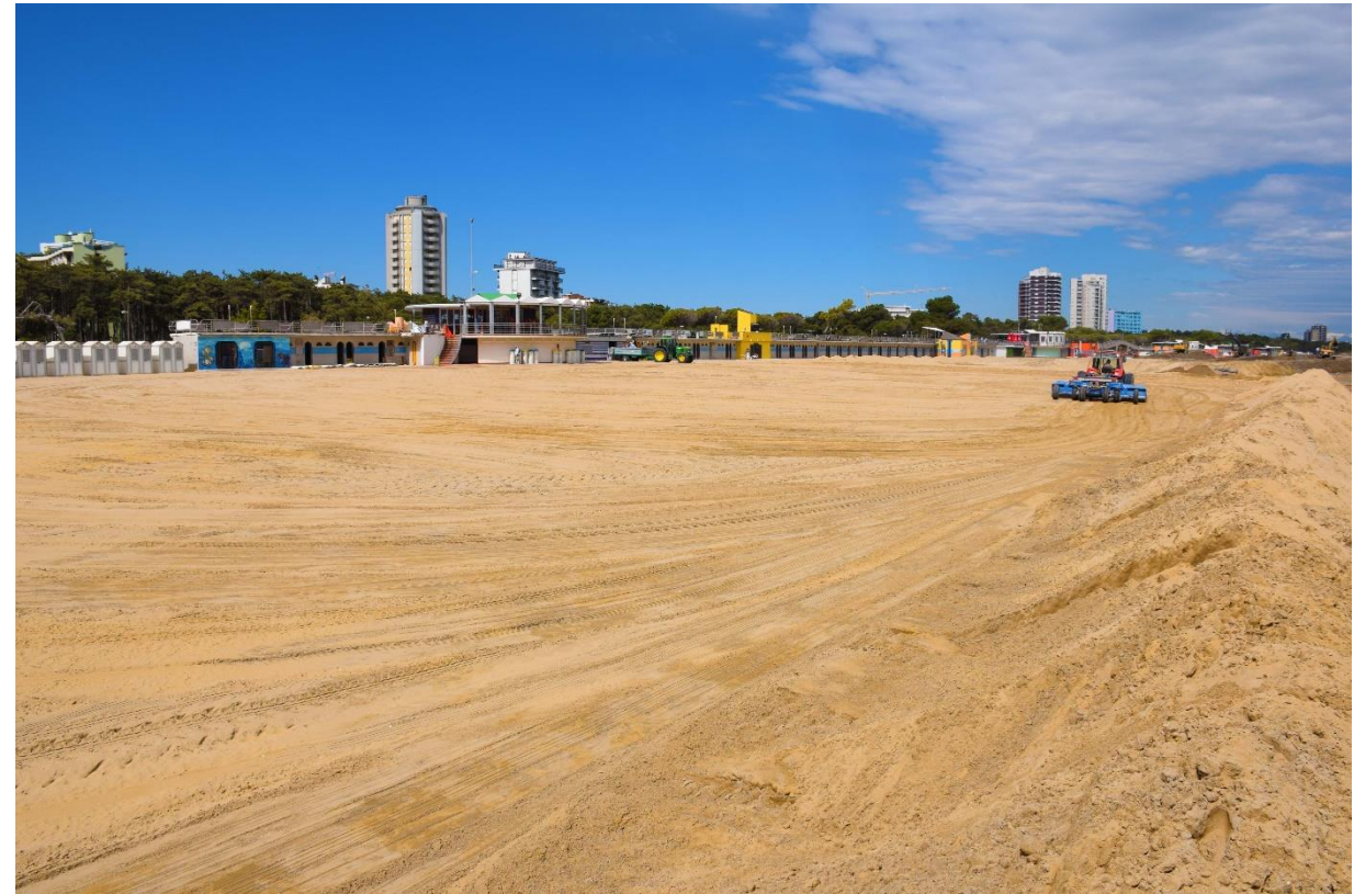
Livellazione e regolarizzazione profilo del litorale
